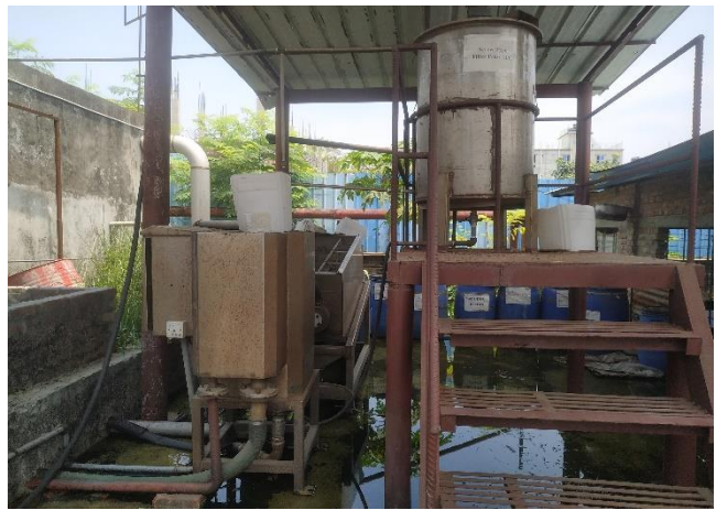
Sludge bed (GPS location: Latitude 24.031687, Longitude: 90.250123)
