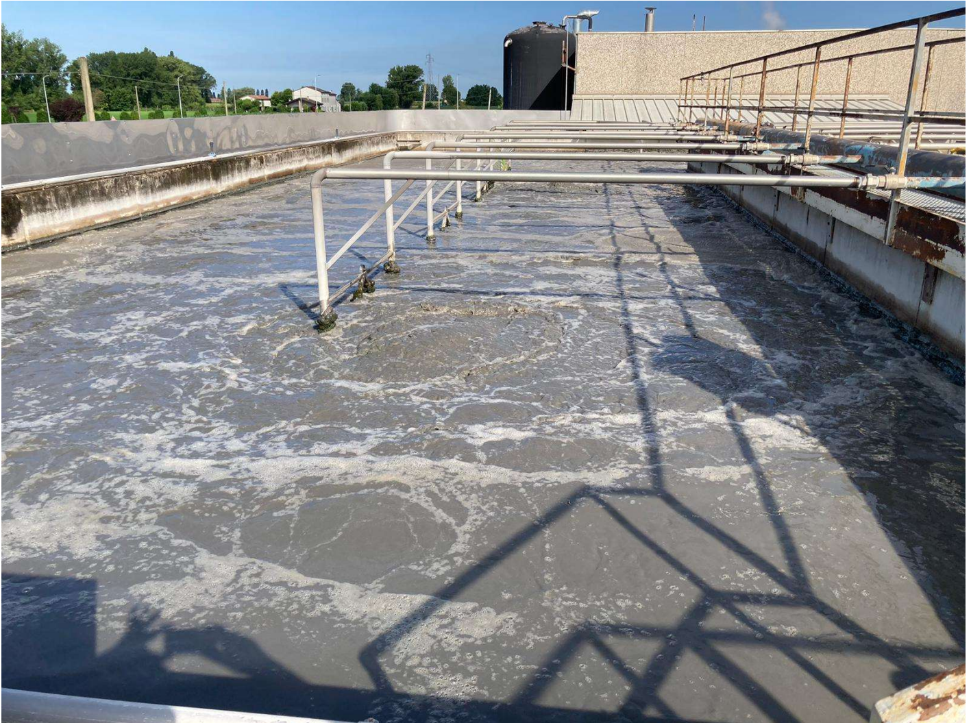
Vasca di accumulo fango
