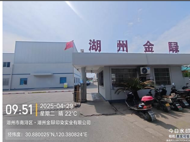
Factory Gate 工厂大门
