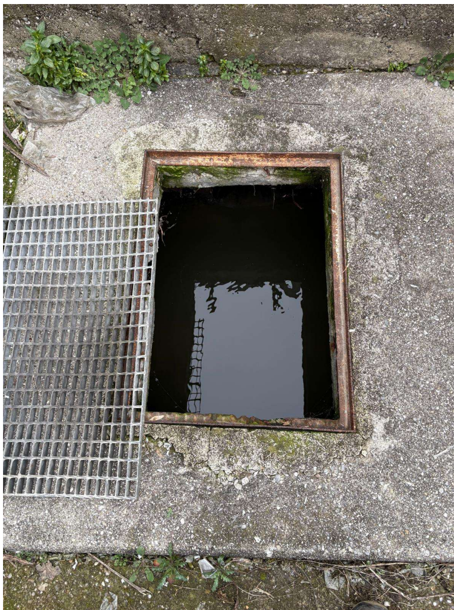
Pozzetto di campionamento post-trattamento
